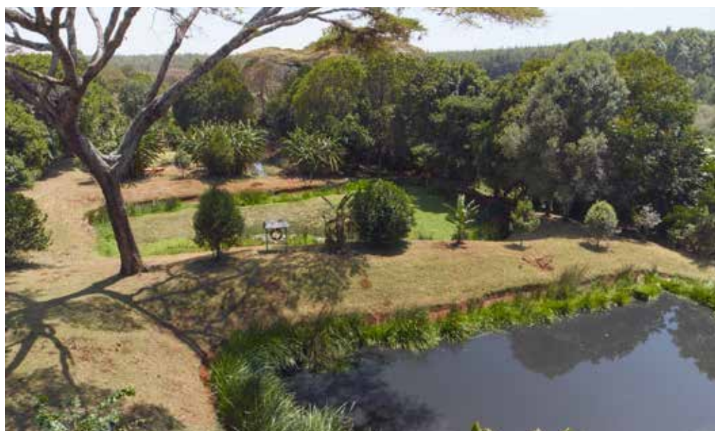
La foto mostra il sistema di 4 bacini interconnessi che sono utilizzati per depurare l'acqua utilizzata durante la produzione di fiori nell'azienda Black Tulip Flowers, in Kenya. ©Fairtrade Czech Republic and Slovakia
